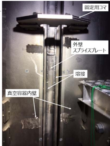
図14: 真空容器最終セクター溶接部拡大図
