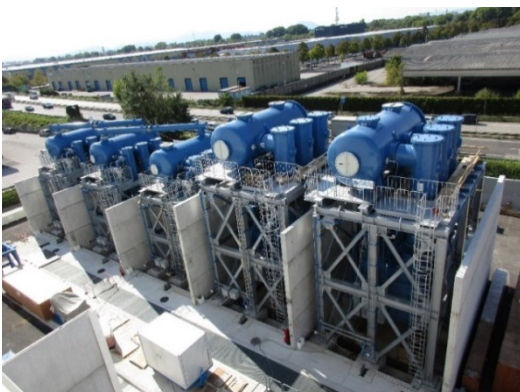
図7: 直流発生器全5台の主要部分の据付完了
