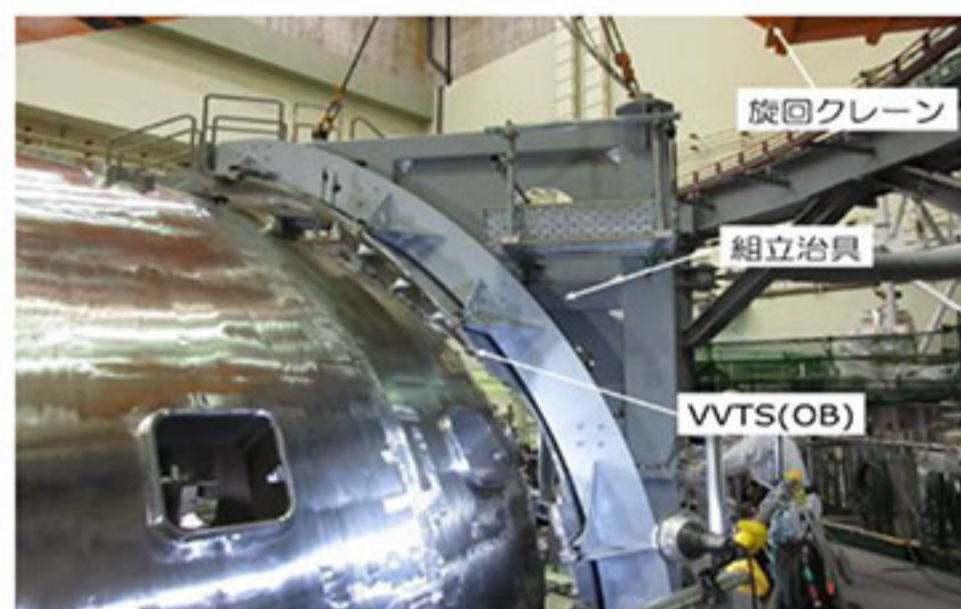
図8: VVTSの吊り込み (VVTSアウトボード(OB))
