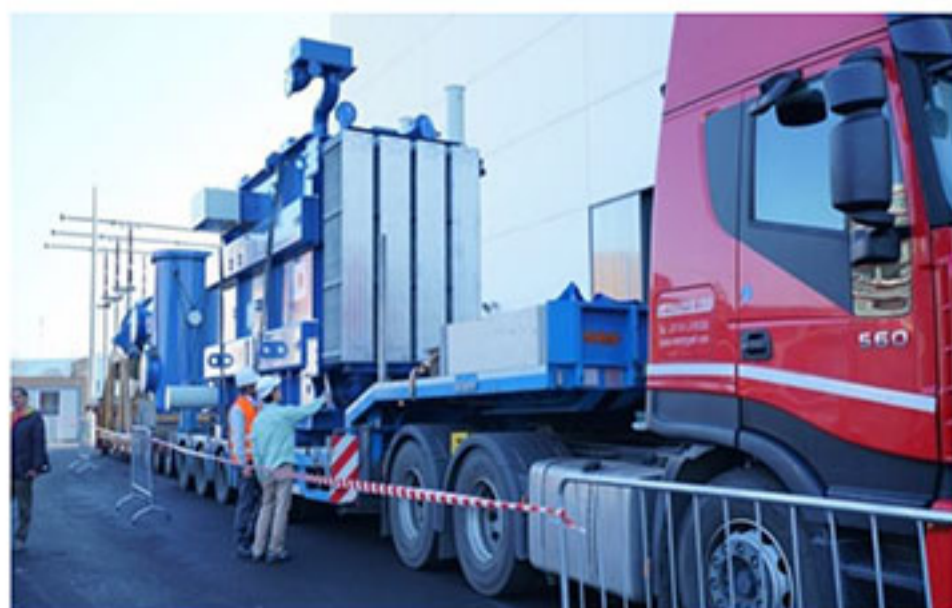
図2: RFXコンソーシアムに到着したNBTF用電源機器(トランスと電送系)
