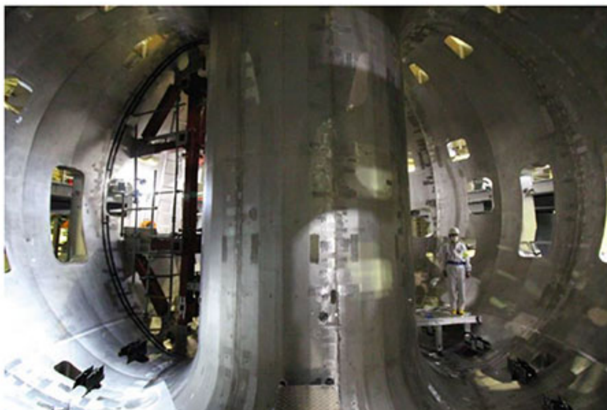
図8: 拘束治具撤去後の真空容器内部
