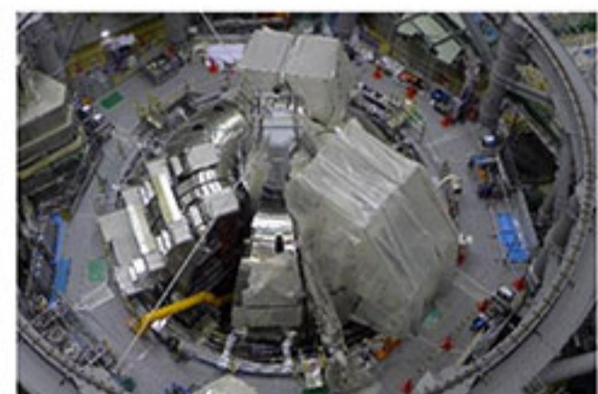
図6: クライオスタットベースに設置した340度の真空容器
