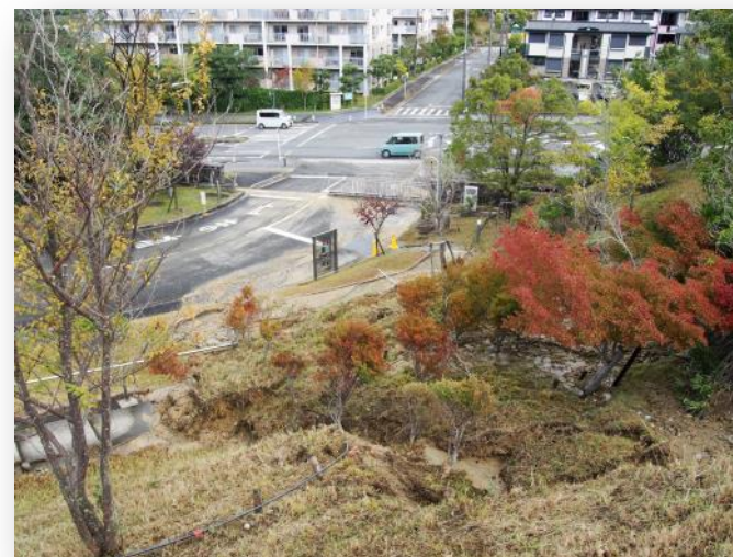
台風21号の影響による法面の崩落 (木津地区)(上及び右下)
