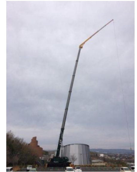
大型クレーン車
