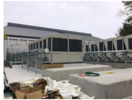
新しい空調設備
