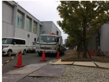
空調工事車両(実験棟南側)
