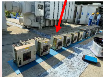
遮断器点検 (機器や電力系統異常時に回路遮断を行う)
