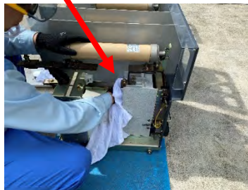
遮断器点検 (機器や電力系統異常時に回路遮断を行う)
