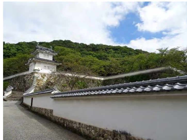
(復元された隅櫓:すみやぐら)
