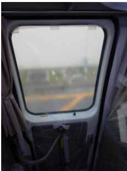
風で剥がれないように、テープ付養生シートの辺縁はテープでしっかりとドアに貼り付ける。
