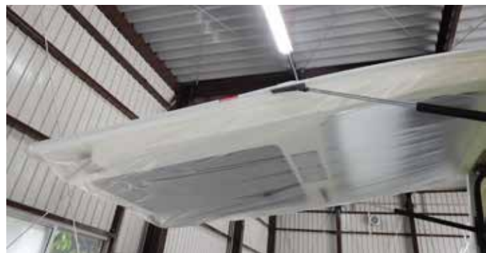
風で剥がれないように、テープ付養生シートの辺縁はテープでしっかりとドアに貼り付ける。
