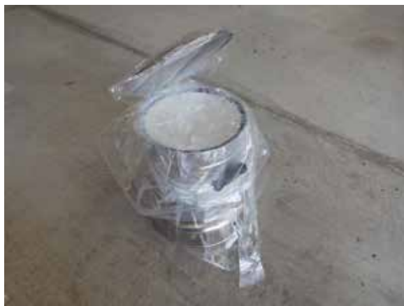
図 12. 搭載器材の養生
