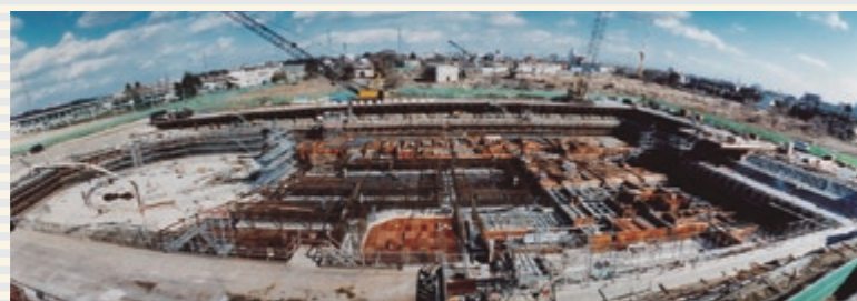
HIMAC(重粒子線治療装置)棟建設工事着工 *1993完成
