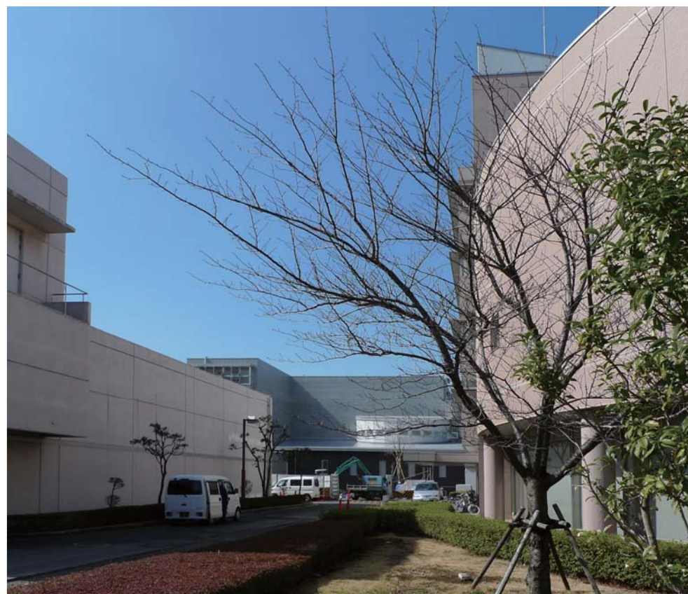
▲重粒子線棟(左側建屋)と重粒子治療推進棟(右側)側から、急ピッチで建築中の新しい重粒子線治療・研究施設を撮影。
