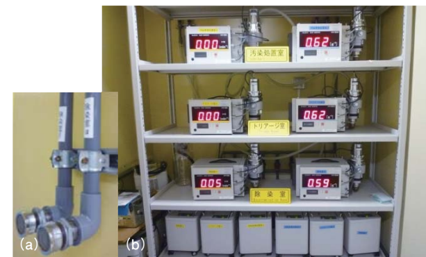
図12: (a)空気サンプリング口 (b)エアモニタ
