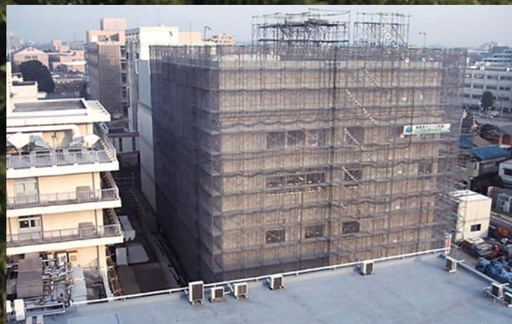
▲新設工事中の分子イメージング棟 (仮称)
