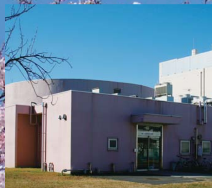
▲静電加速器棟
