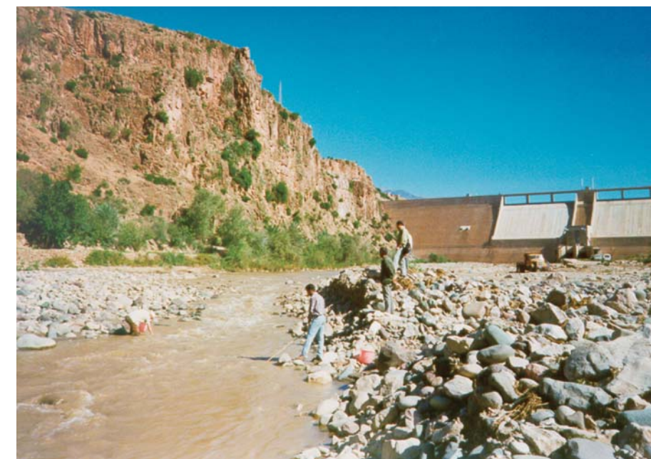
図5：アイソトープ技術を用いたダムへの漏水検査 (IAEA NA Presentationより)
