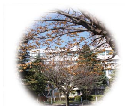
講堂側から見た第1研究棟
