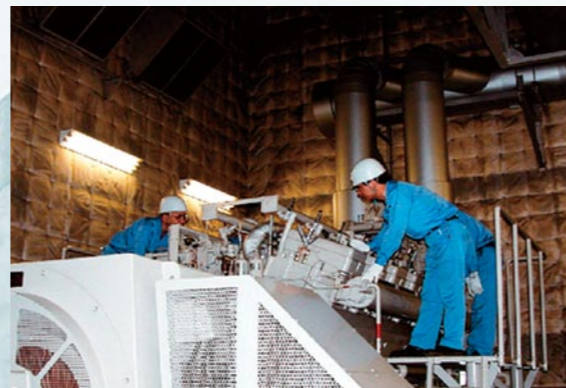
自家発電設備の安全点検
