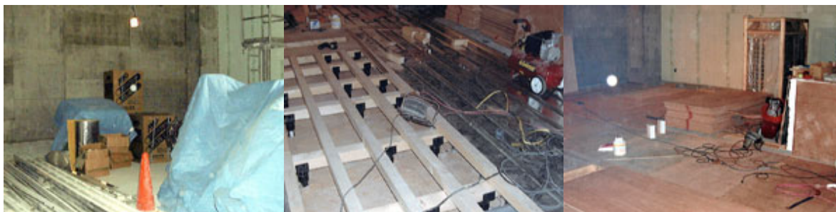
写真2 工事前のNMR室
