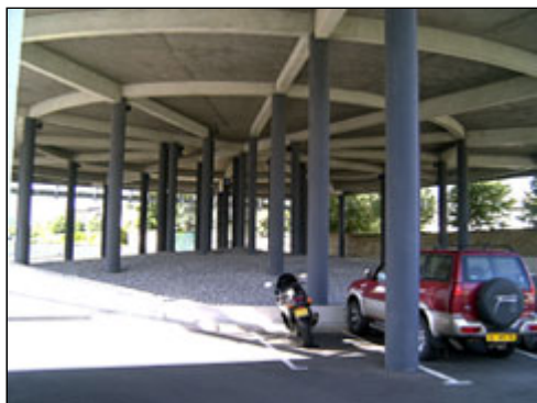
図1 Hospital Percy CTB(仏)に設置されたヘリポート。この下の一部は駐車場となっている。
