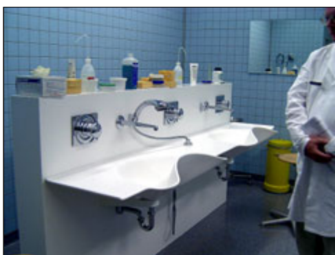
図3 Karlsruhe(独)研究所の除染室にある洗髪台。体がフィットするように工夫がされている。患者が入る反対側には、介助者が立てるように壁との間にはスペースがあり、台自体が遮蔽物となる。
