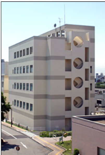
探索研究棟外観
