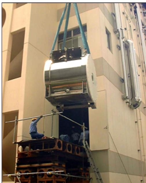
図-1 7Tマグネットの探索研究棟2階NMR撮影室への搬入
