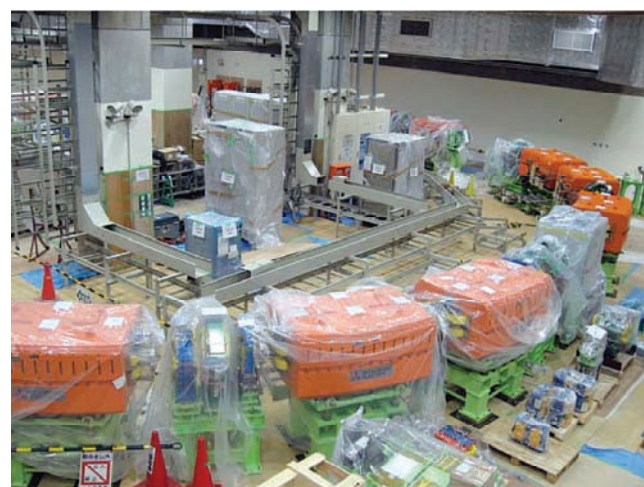
写真3: 据え付け作業中のシンクロtron。小型ながらHIMACと同等の性能を実現。
