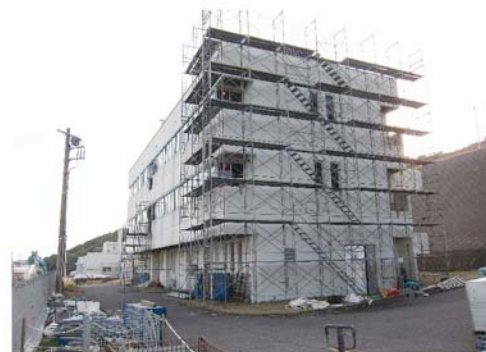
写真1 解体作業が進む第3研究棟外観
