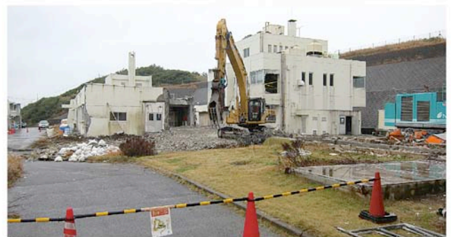
写真2 解体作業中の那珂湊支所
