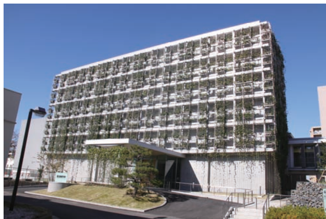
写真2 植栽で壁面緑化されている新治療研究棟
