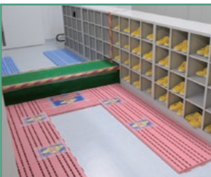
② 管理区域の中に緩衝区域(すのこ)を設け、外履きと内履きを履き替えるようにしている
