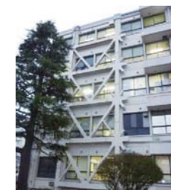
第1研究棟(補強後)
