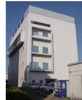
図4:低線量影響実験棟
