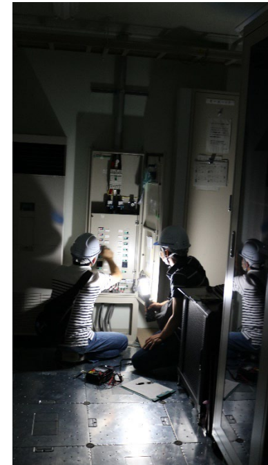
放射光物性研究棟の実験室で分電盤の絶縁抵抗を検査する職員【撮影：庶務課(播磨地区)】
