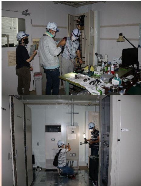
放射光物性研究棟の実験室で分電盤の絶縁抵抗を検査する職員【撮影：庶務課(播磨地区)】
