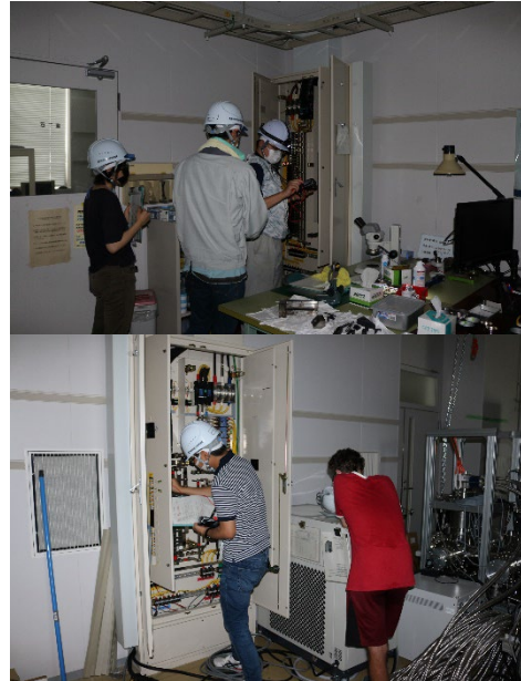
放射光物性研究棟の実験室で分電盤の絶縁抵抗を検査する職員【撮影：庶務課(播磨地区)】
