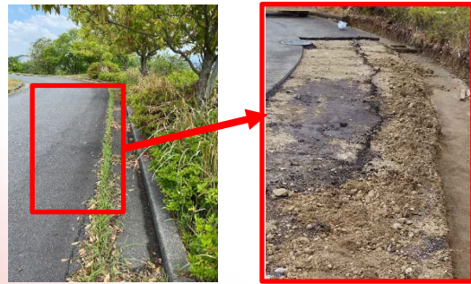
亀裂状況(工事前)
