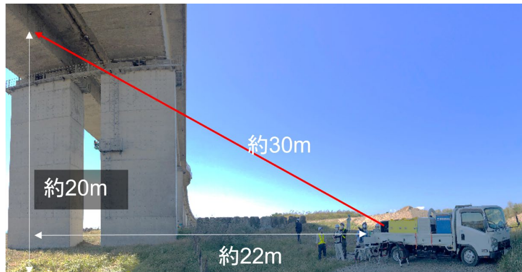
供用中の道路橋でのレーザー打音検査の様子(プレスリリースより)
