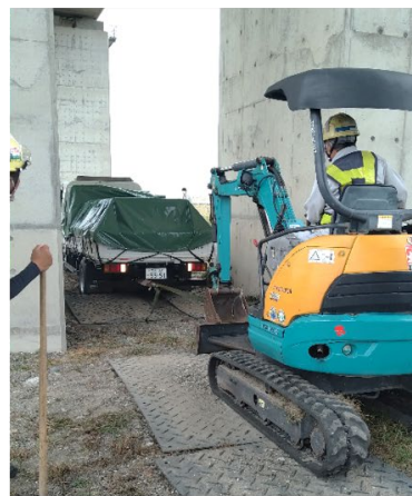
橋梁の真下のぬかるみから 救出されるレーザー打音車両
