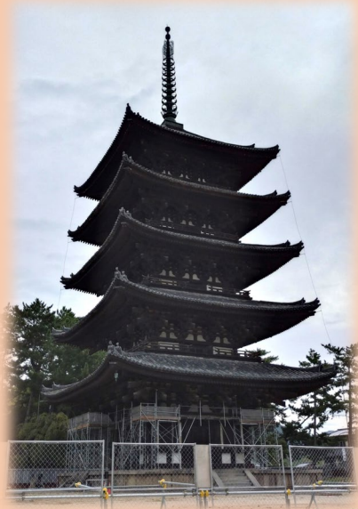
塔の下部が既に素屋根（足場）に覆われつつあります。
