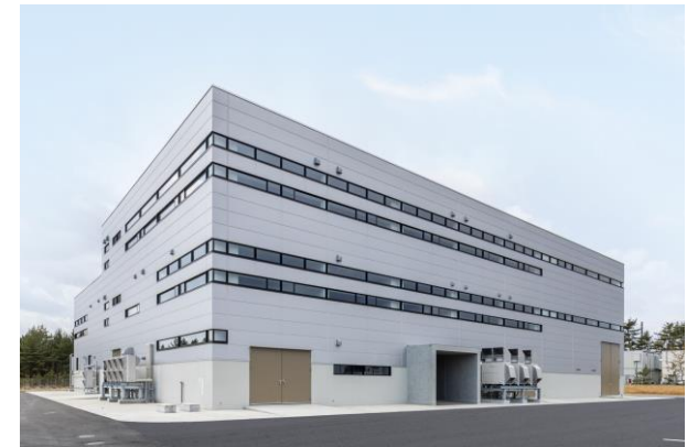
六ヶ所研のブランケット工学試験棟(R3年度完成)、安全実証試験装置群(R4年度据付完了)
