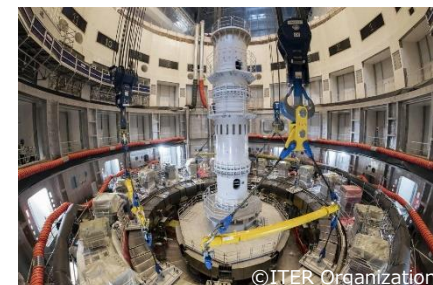
(トカマクビットに据付けられるPFコイル)
