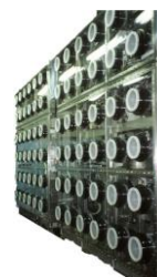
MOX燃料 製造設備
