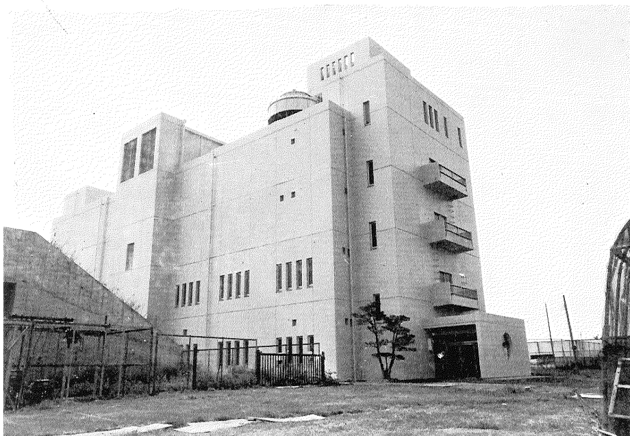
晩 発 障 害 実 験 棟
