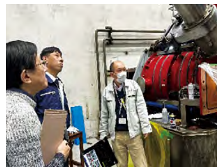
千葉地区 サイクロロン棟
