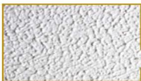
外壁工事は、旧塗装をはがし、模様を付け、その上からさらに塗装します。職人さんの技術によって模様は完成します。全面塗り替えを行ったので一面きれいな外壁になりました。
