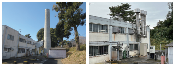
解体前の煙突（左）と新設された排気塔（右）
