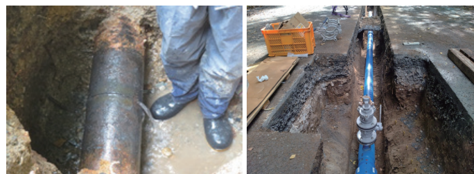
漏水した旧配管（左）と工事後の新配管（右）
