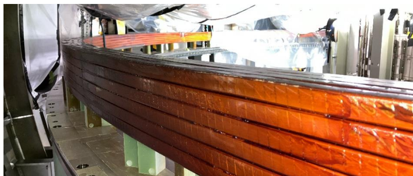
上FPPCコイル 絶縁硬化完了状態 (2025年1月, 真空容器内にて撮影)
