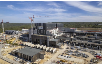
ITERサイトの建設状況
