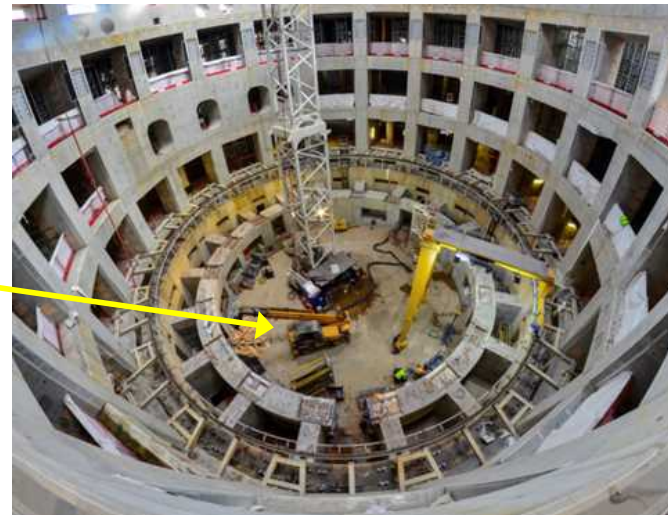
トカマク設置場所(2018年8月)
