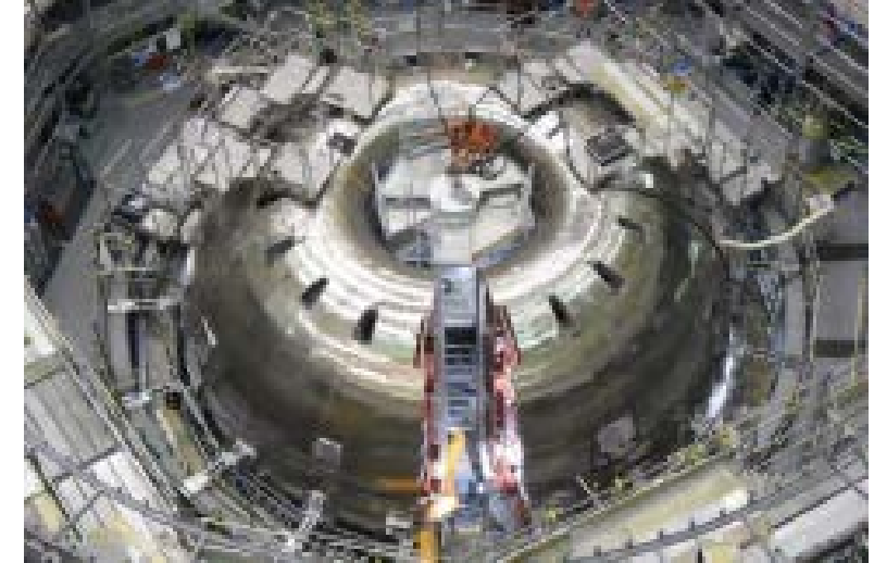
真空容器340°設置完了
