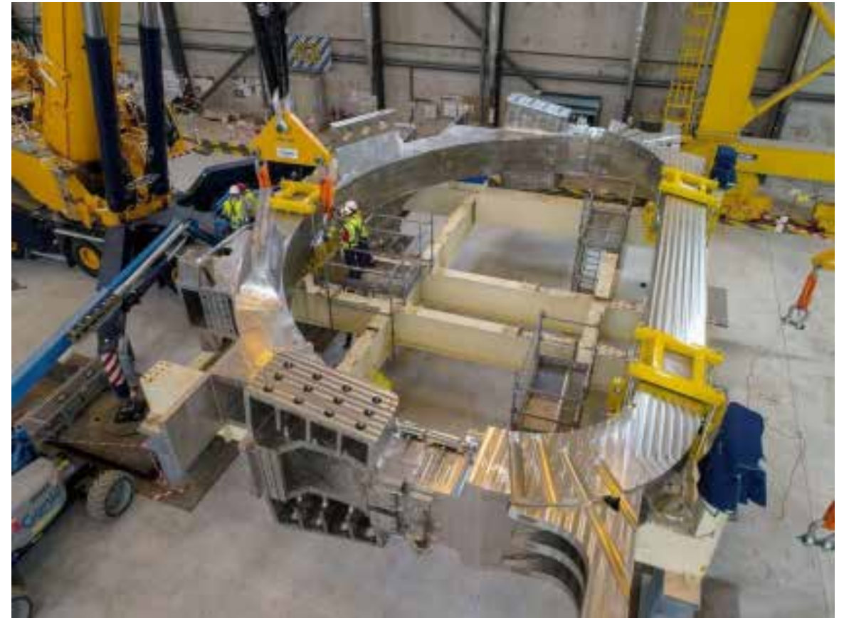
輸送フレームを外した状態 本年6月20日
