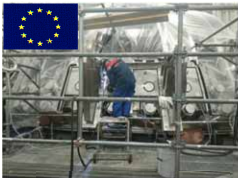
溶接作業中の#5セクター
