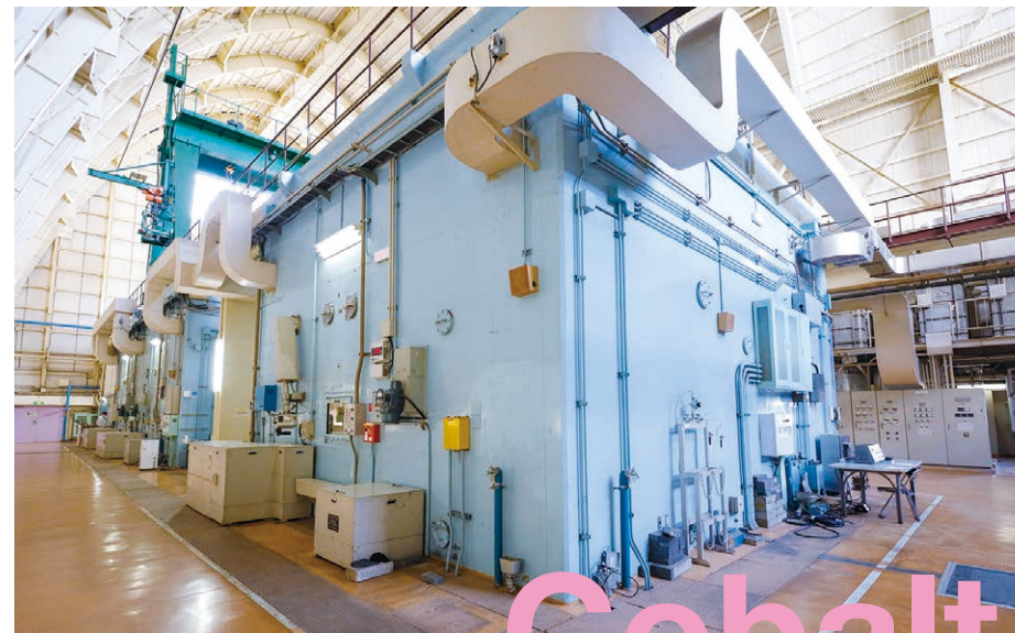
施工当時もつとも建屋強度の高い形状を模索した結果、第1照射棟には天井の高いドーム型が採用された。
