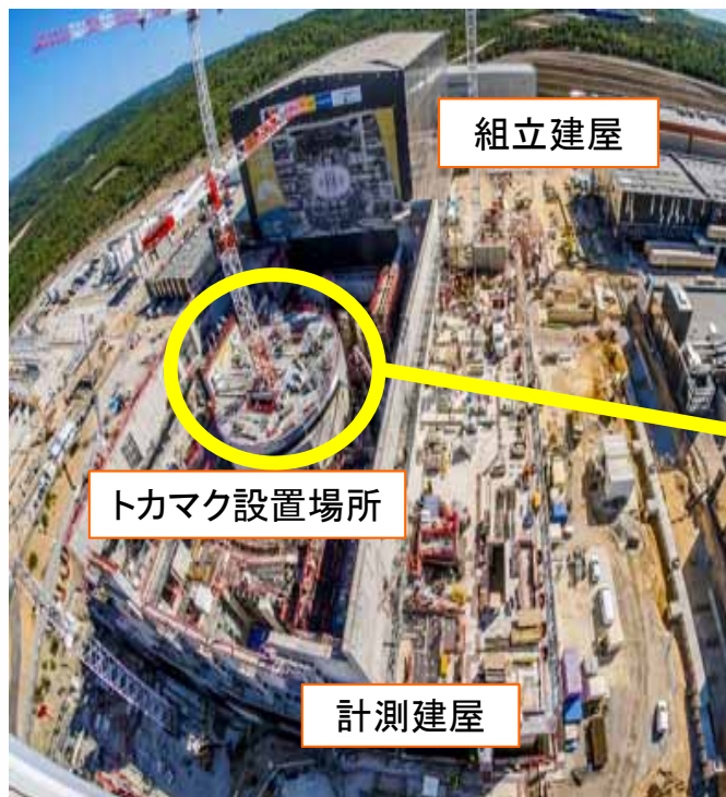
トカマク建設現場(2018年10月)
