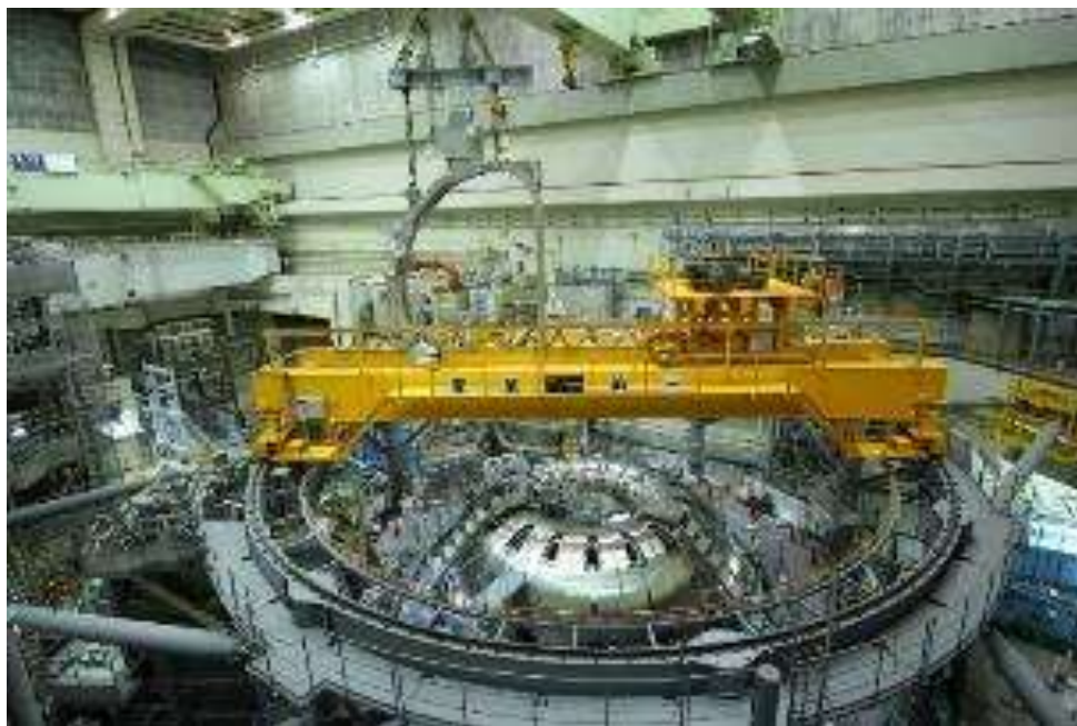
トロイダル磁場コイル設置の様子
