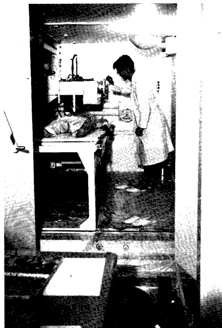
◀昭和36年3月 ヒューマン・カウンタ(体内微量放射能測定装置)設置。人体内の微量放射能の量や分布を測定する装置で、病気や放射線被曝者などの診断に用いられ、今もってその重要性は高い。
