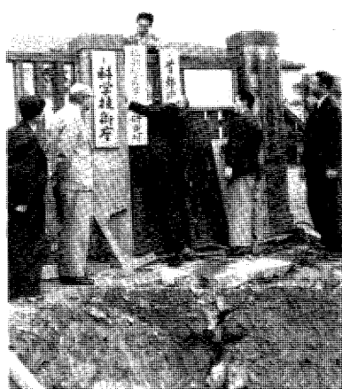
▲昭和32年7月1日 発足当日、本研究soの標札を掲げる篠原科学技術庁事務次官、左は樋口所長。(霞ヶ関科学技術庁庁舎)
