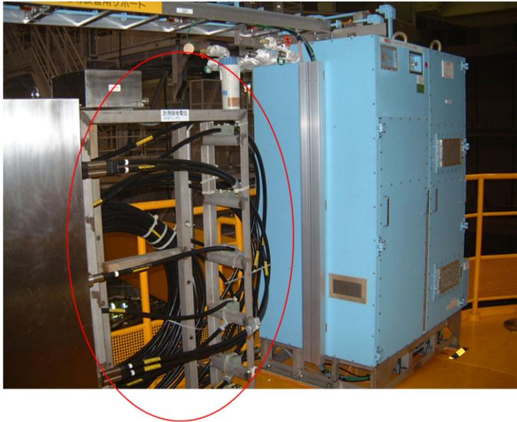
図3 JT-60 で使用時の伝送系光ファイバーバンドル支持構造物
