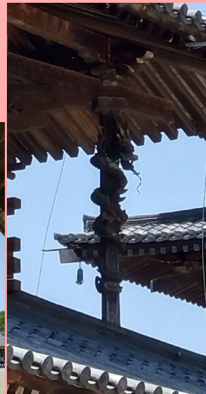
よく見ると金堂の柱には龍の装飾が施されている。
